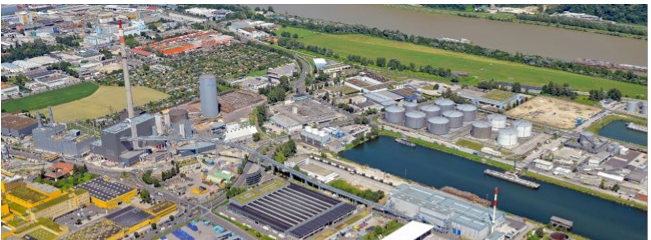
Der moderne Kraftwerkspark der LINZ AG am Standort Linz-Mitte.
