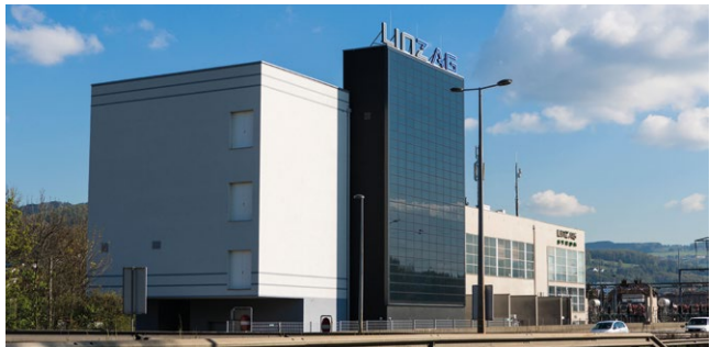
Das IT- und Data Center der LINZ AG TELEKOM zählt zu den sichersten und modernsten Rechenzentren Österreichs.
