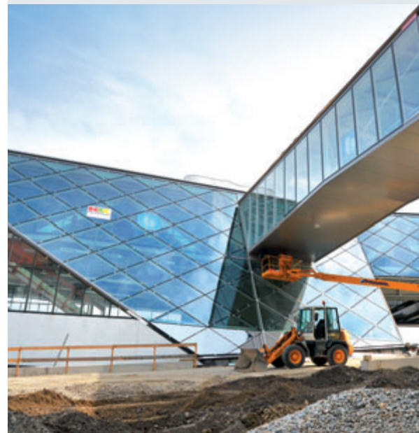
Am 3. Juli erfolgt die Eröffnung des neuerrichteten Südflügels des
