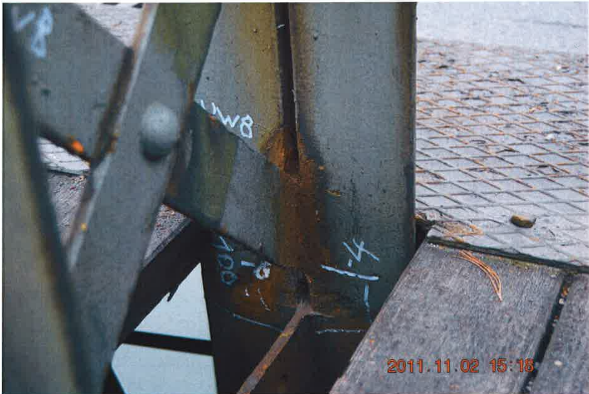
Bild Nr.: 460: Starke Abrostung der Vertikale V8 im Spalt bei Diaphragmablech und Stabauskreuzung Diese Abrostung ist bei nahezu allen Vertikalen anzutreffen und reduziert diese sichtbaren Schenkel um durchschnittlich 5 mm! Auch der abgewandte Schenkel wird durch die Spaltkorrosion um ca. 2 mm reduziert. Siehe Skizze Seite 126, Vertikale V8!
