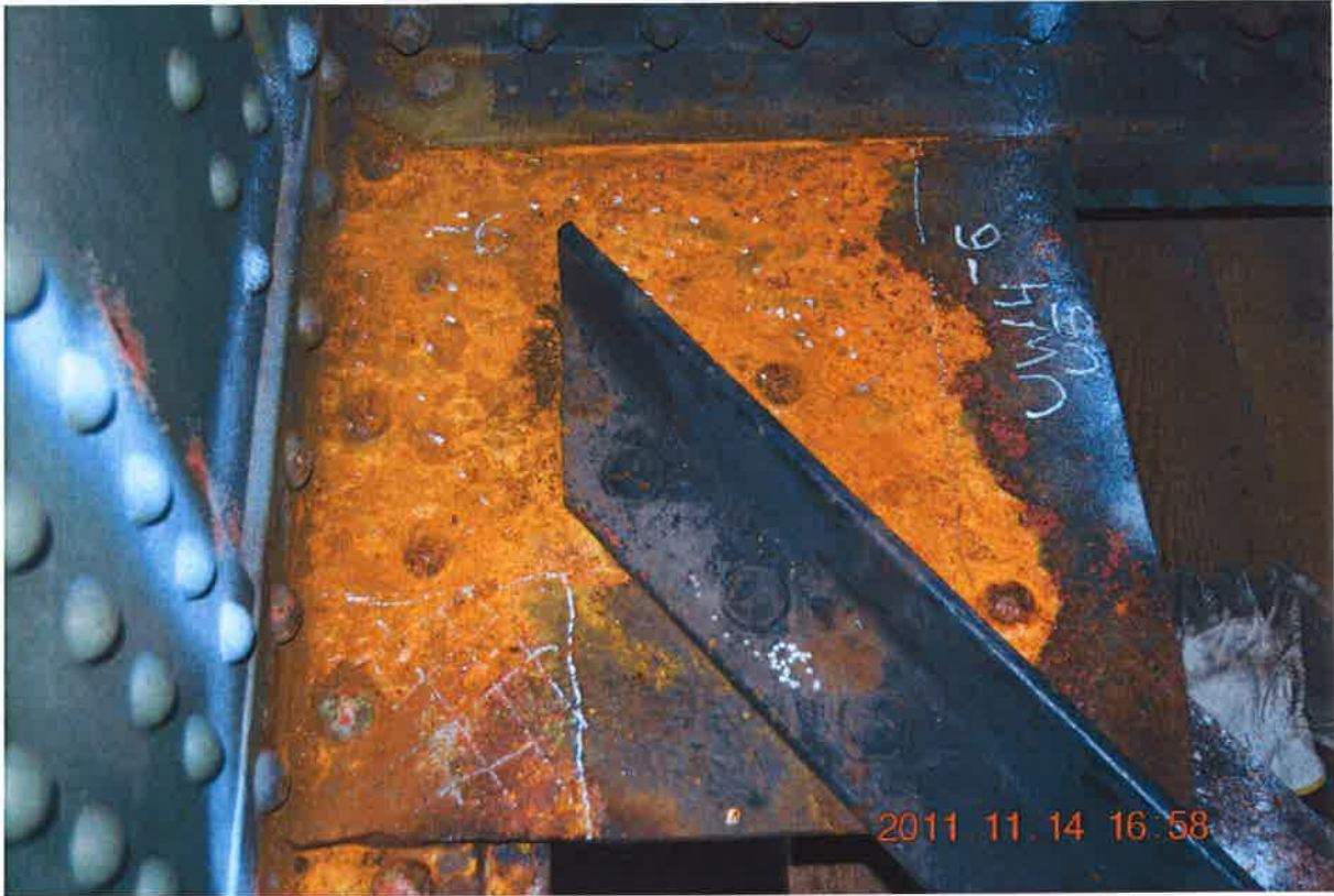
Bild 1879: TW2, UW4, Seite 76, Teilweise durchgerostetes Windverbandsknotenblech mit 3 verrosteten und weitere 2 angerostete Nietköpfen. Diese Nieten verbinden Knotenblech, Gurtwinkel und 4 Gurtlamellen!
