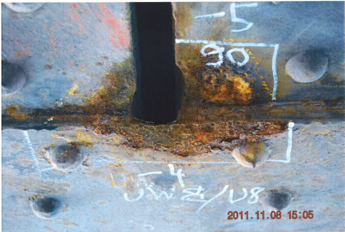
Bild 1243: TW1, UW8, U8: Abrostung des Bindebleches und Gurtlamellenpakete bei Querträger 8: Dieses Blech verbindet die beiden Untergurtquerschnitte und ist zur Einleitung der Windverbandskräfte in die beiden Untergurteile erforderlich. Im Bild ist der Spaltrost zwischen dem Bindeblech und den unteren Gurtlamellen und die seitliche Abrostung der 6 Gurtlamellen im offenen 34 mm Spalt zu erkennen. Siehe Skizze Seite 125!
