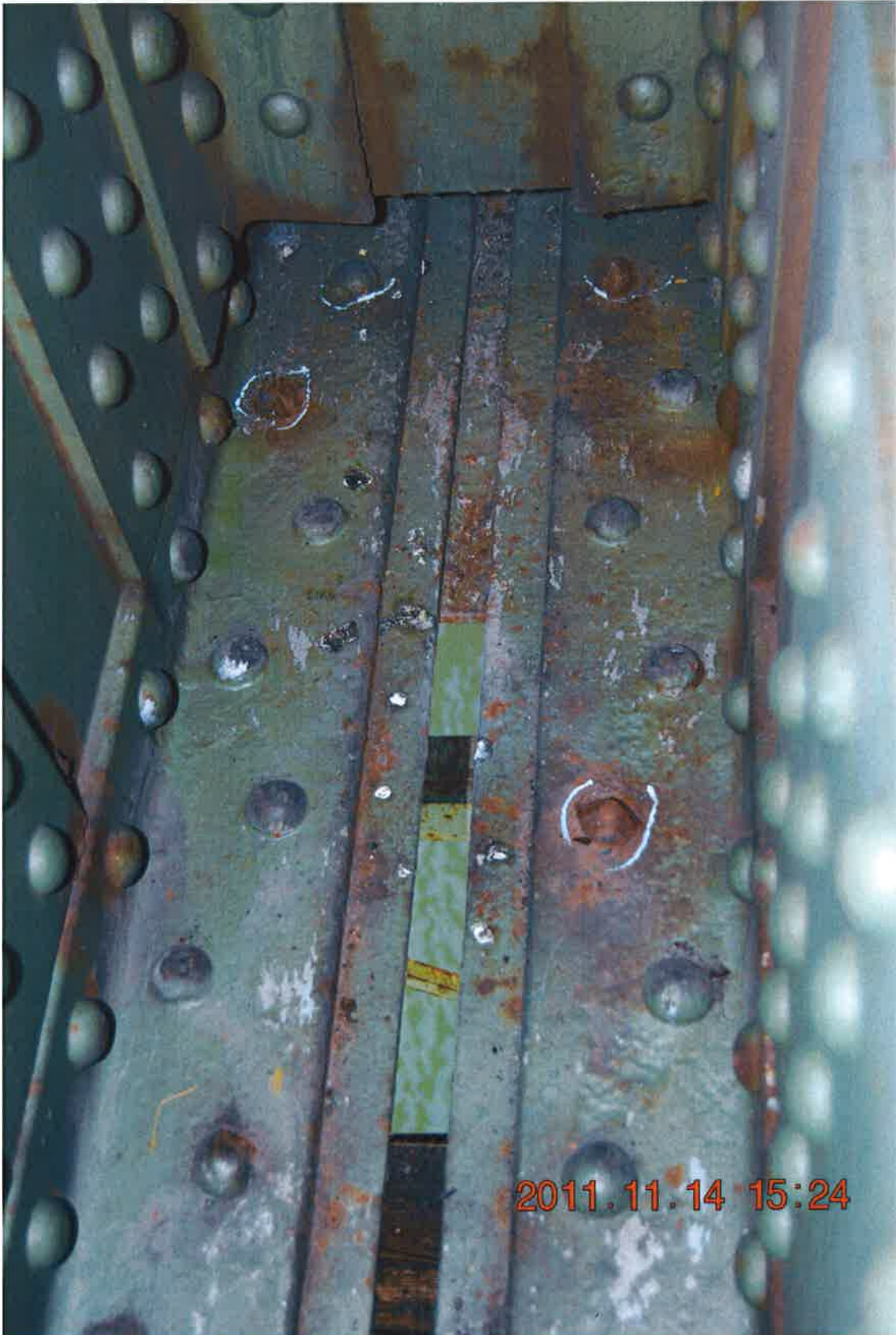
Bild 1802: TW2. UW2, siehe Seiten 47, 50! Bei Verbindung der Untergurtlamelle mit dem Untergurtwinkel im Bereich U2/U3 sind Nietköpfe stark angerostet!
