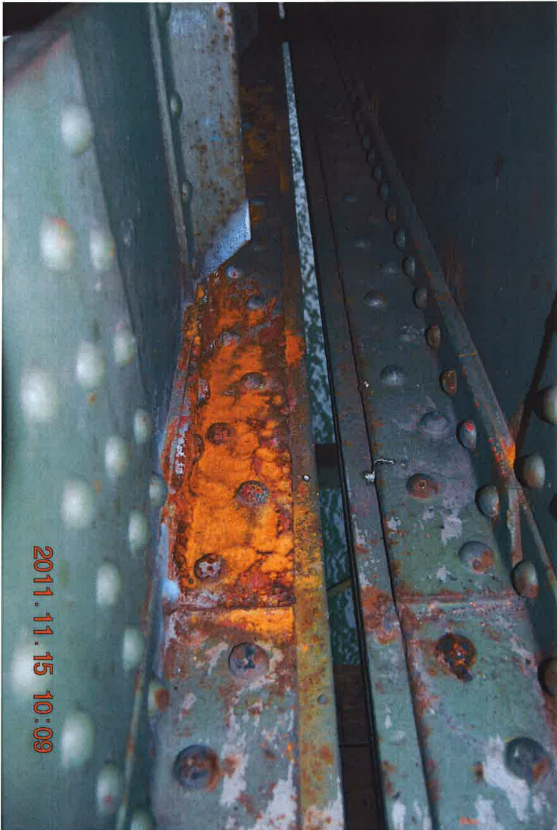
Bild 1955: TW2, UW6, U6, siehe Seite 102, innerer stark angerosteter Gurtstoßwinkel mit ebenso angerosteten Nietköpfen!
