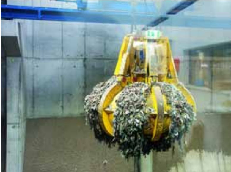
Ein computergesteuerter Greifer befördert den aufbereiteten Abfall zum Rohgurtförderer.
