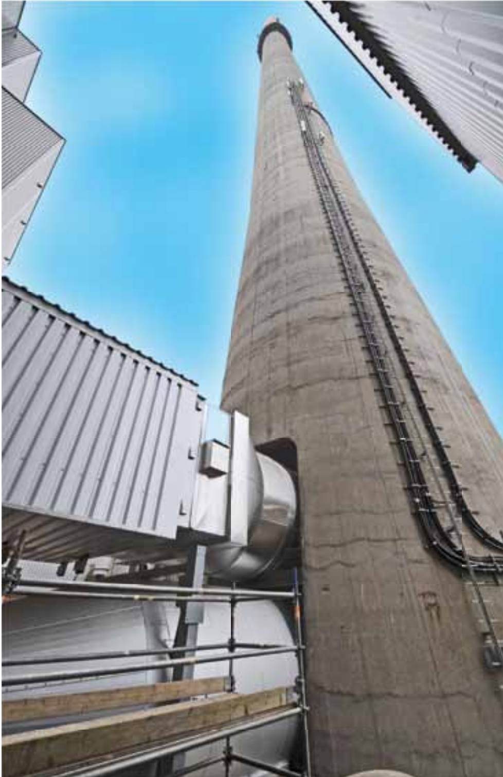
Die aufwändig gereinigten Abgase werden in den 184 Meter hohen Kraftwerkskamin geleitet. (Foto: KOMM)
