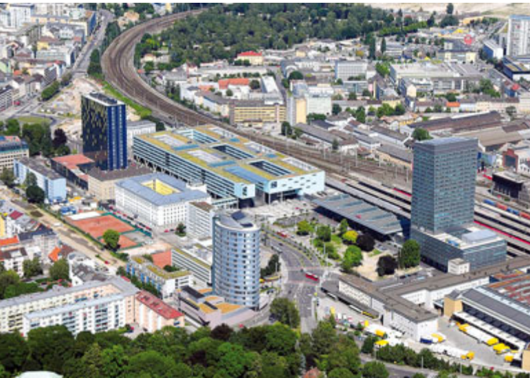
In den vergangenen Jahren hat das Bahnhofsviertel ein völlig neues Erscheinungsbild erhalten, das vom Fachwissen des Gestaltungsbeirates positiv beeinflusst wurde.
