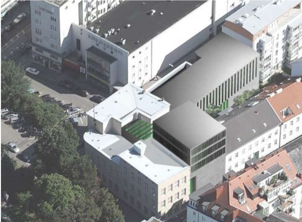
Die Gleichenfeier für den neuen Turm der OÖ. Landesbibliothek an der Rainerstraße findet am 21. Oktober 2008 statt.
