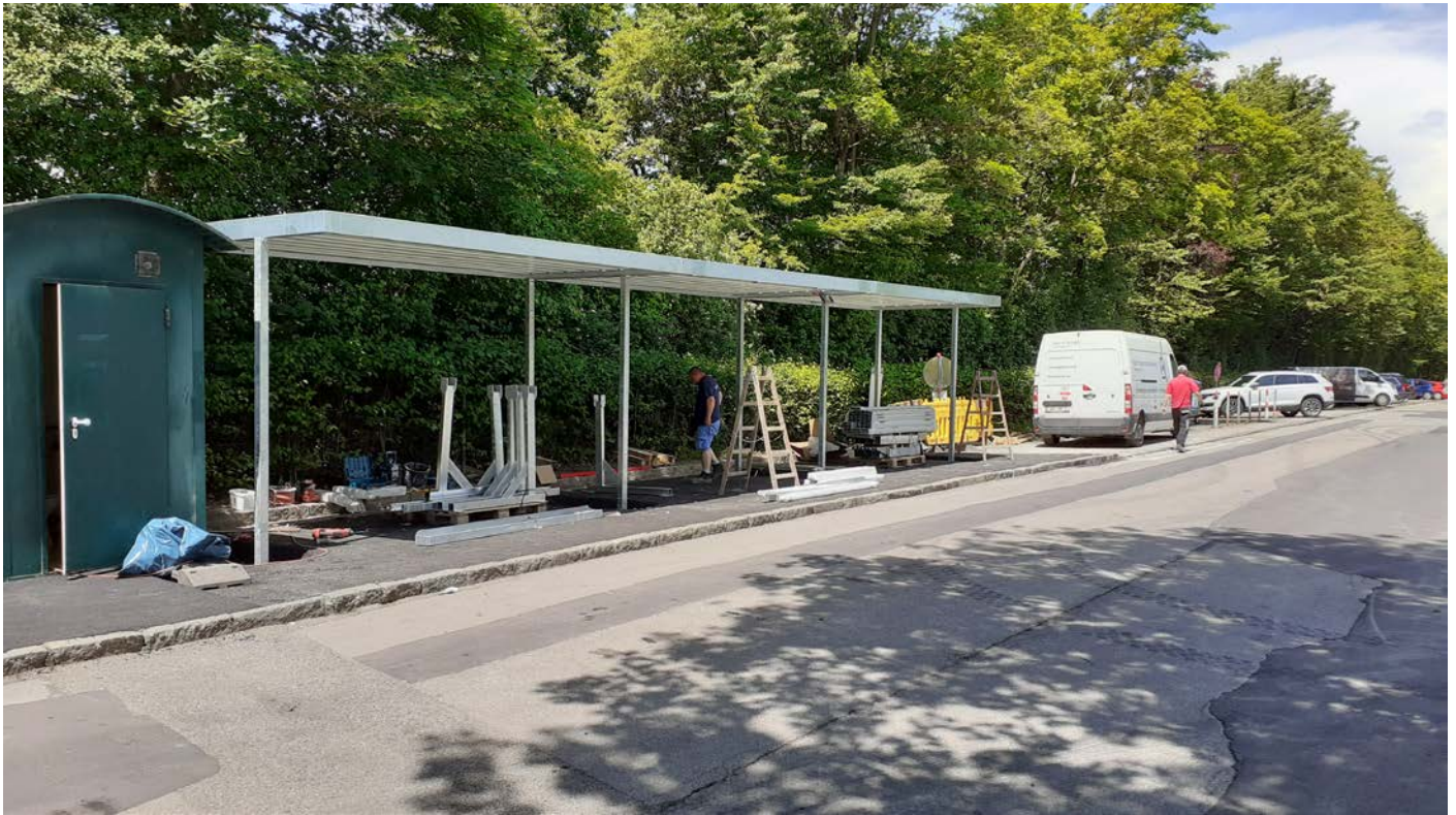
Fundamente, Erweiterung der Aufstellfläche sowie Überdachung / Radabstellanlage
