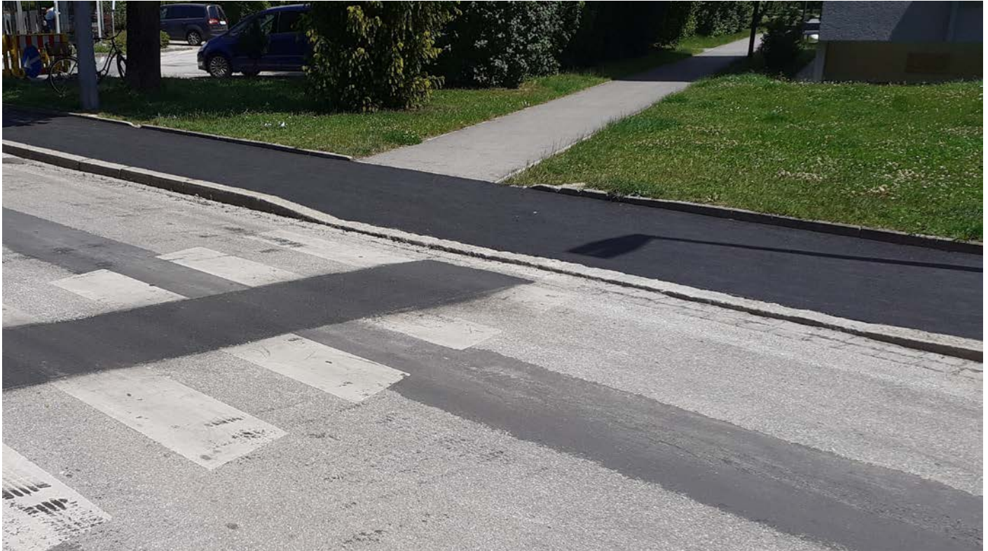
Belagsanpassung und Absenkung / Gehsteig
