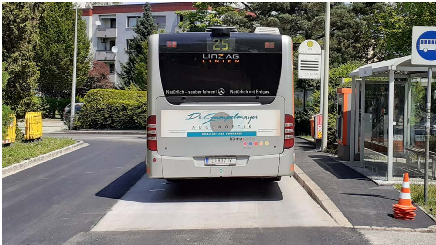
Neue Deckschicht / Aufstellfläche Bushaltestelle
