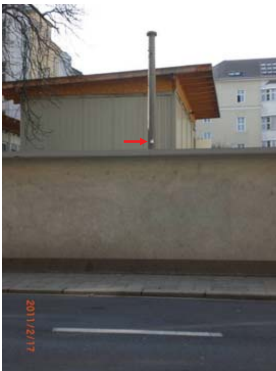
Anhang A, Foto 30: MP 15_ Goethestraße – Humboldtstraße, Detailansicht
