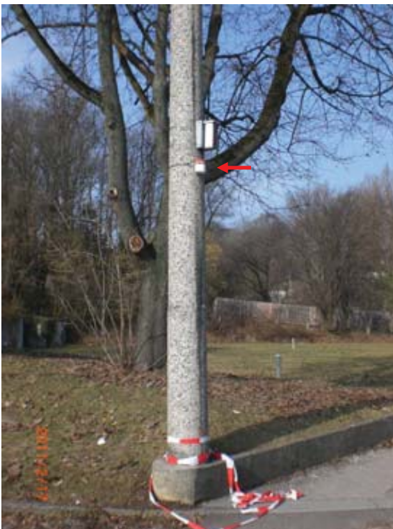
Anhang A, Foto 10: MP 5_ Postgarage, Detailansicht
