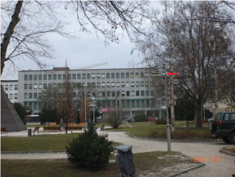
Anhang A, Foto 11: MP 6_ Hessenplatz, Übersichtsbild
