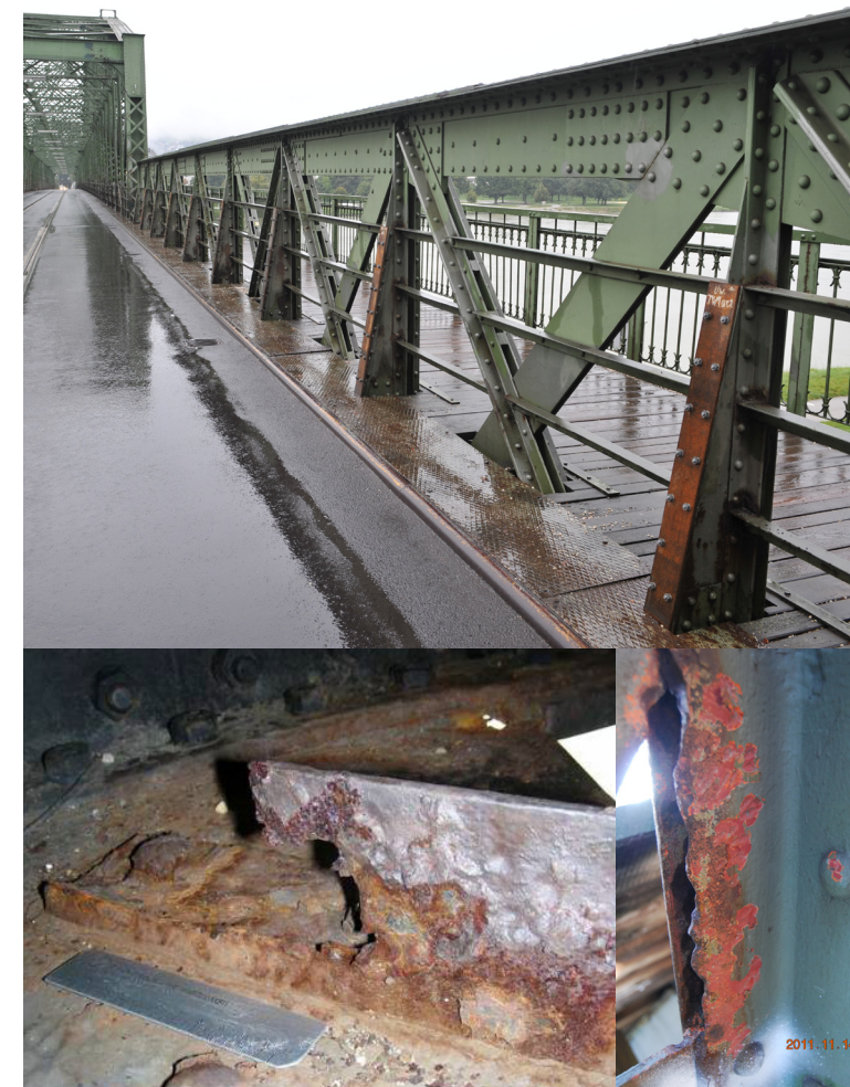
Massive Korrosionsschäden an der Eisenbahnbrücke vor den Reparaturarbeiten im Herbst 2012
