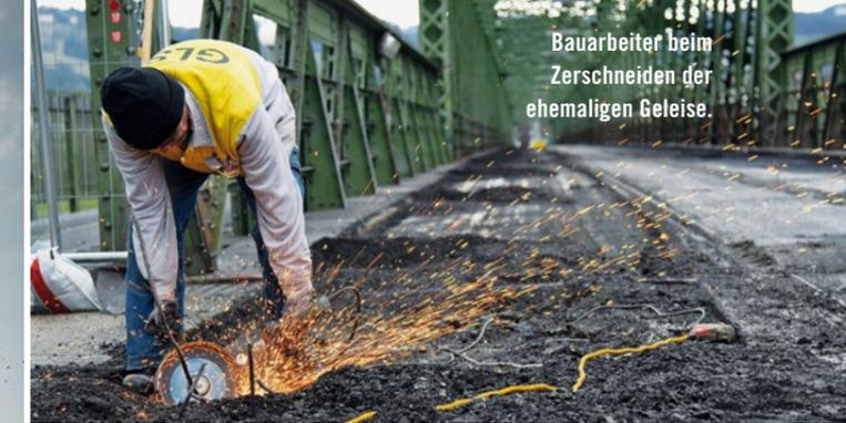
Bauarbeiter beim Zerschneiden der ehemaligen Geleise.
