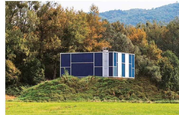
Wasserwerk Plesching. Das neue Brunnengebäude befindet sich hochwassersicher auf einem Erdwall.
