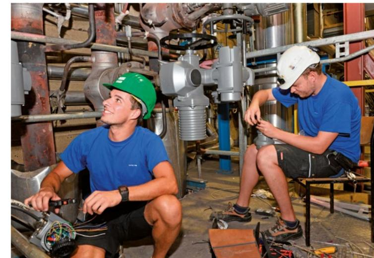
Revitalisierung im Fernheizkraftwerk Süd: Bernhard Hofstätter (l.) und Patrick Floh (beide LINZ AG) beim Anschließen neu eingebauter Armaturen mit elektrischem Antrieb.
