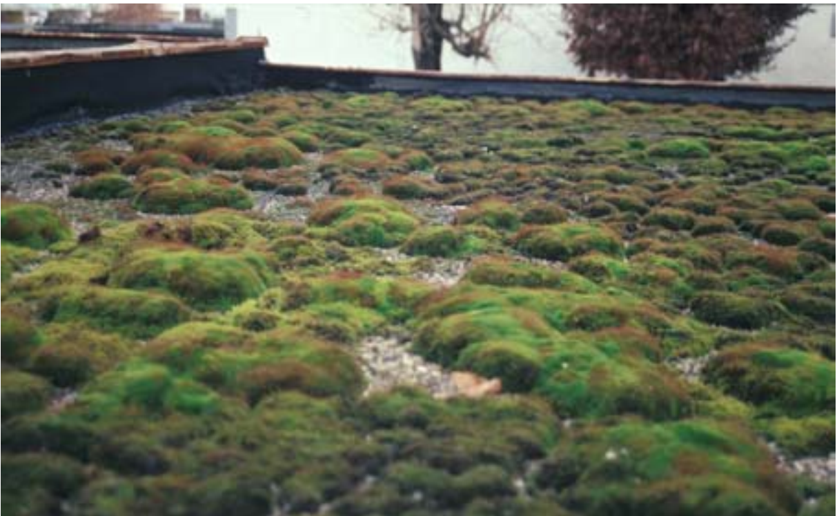
Abbildung 3: Üppige Bodenmoosvegetation auf einem mit Feinschotter bedecktem Flachdach.
