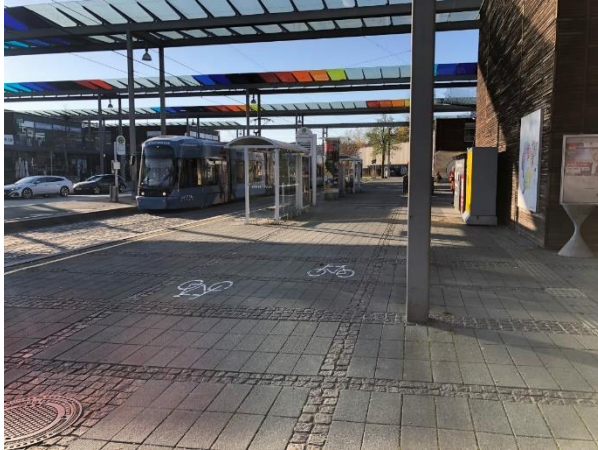
Abbildung 50: Überdachter Haltestellenbereich Solar-City
