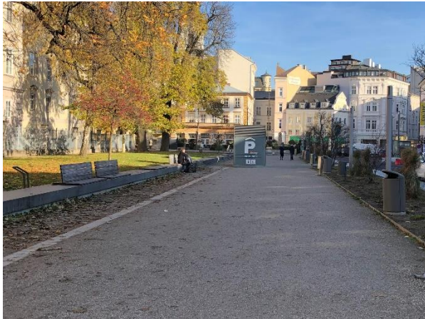
Abbildung 56: Versickerungsfähige Gehfläche Promenade
