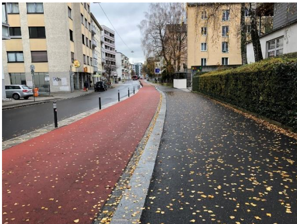
Abbildung 36: Getrennter Geh- und Radweg Lederergasse
