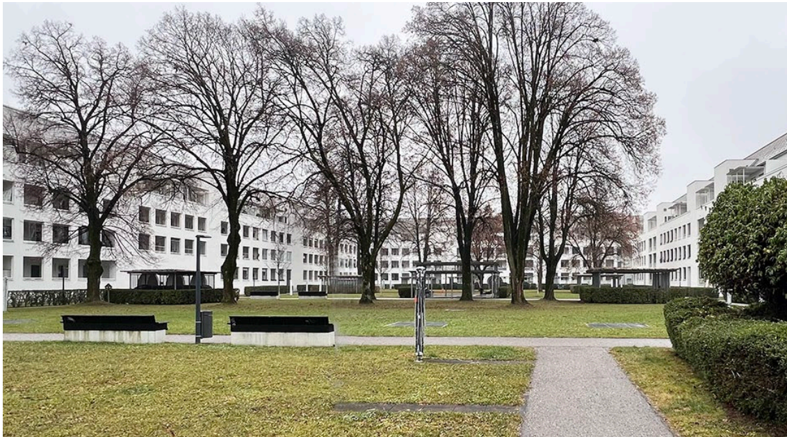
Abbildung 5: Bestandstransformation eines WAG-Hofs am Bindermichl: Aufstockung, Barrierefreimachung, Schaffen von privaten Freiräumen (Architekt: Prof. Franz Riepl, Fertigstellung 2020)
