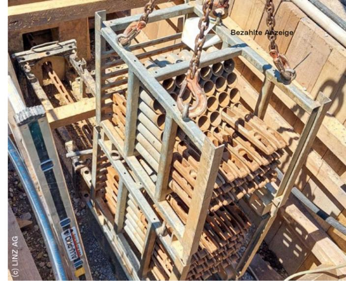
Die Wasserleitung wurde mittels „Berstlining“ erneuert. Am Bild ist das hydraulische Bohrgestänge zu sehen.
