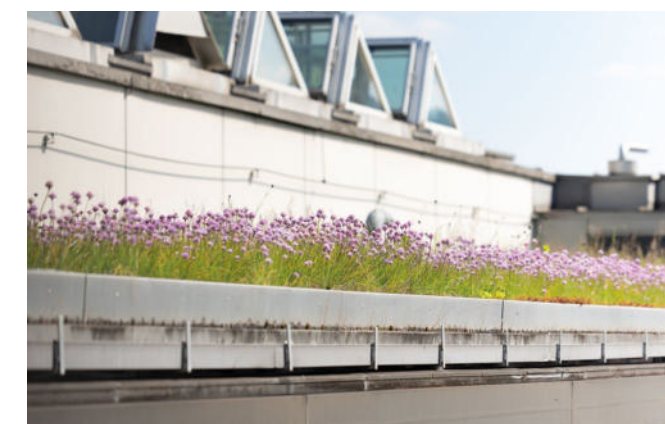
Dachbegrünung auf dem Alten Rathaus.
