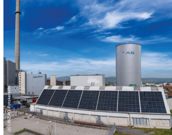
Die PV-Anlage der heurigen „Sonnenschein“-Aktion befindet sich am Dach des Hackschnitzzellagers im Energiepark Linz-Mitte.
