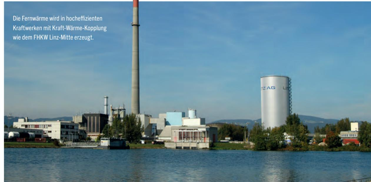
Die Fernwärme wird in hocheffizienten Kraftwerken mit Kraft-Wärme-Kopplung wie dem FHKW Linz-Mitte erzeugt.
