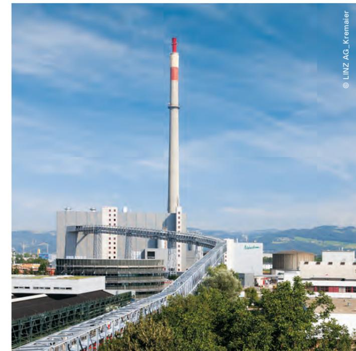
Über eine Rohrgurtförderanlage gelangen aufbereitete Reststoffe zur Strom- und Fernwärmeerzeugung ins Reststoffheizkraftwerk.
