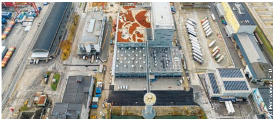
Am Dach der Pharmahalle ist das Wegenetz (hell) sowie die Bereiche für Pflanzen (dunkel) erkennbar.
