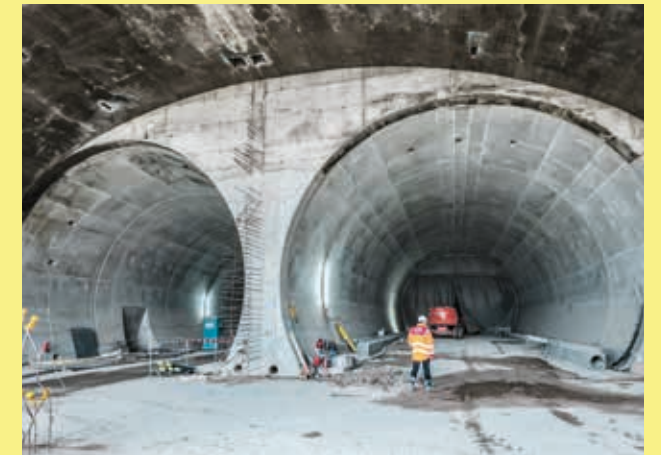
Die Tunnel für die Auf- und Abfahrten sind im Rohbau fertig.
