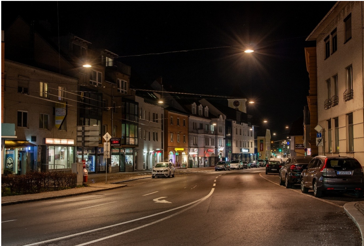
Bild 3: Ortskern Ebelsberg mit Durchzugsstraße und Straßenbahn, © Stadt Linz/PTU
