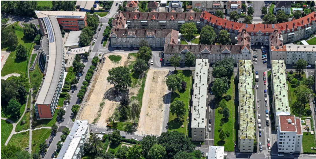
Areal des „Wimhölzel Hinterlands“; Luftbild Stadt Linz, Heimo Pertlwieser
