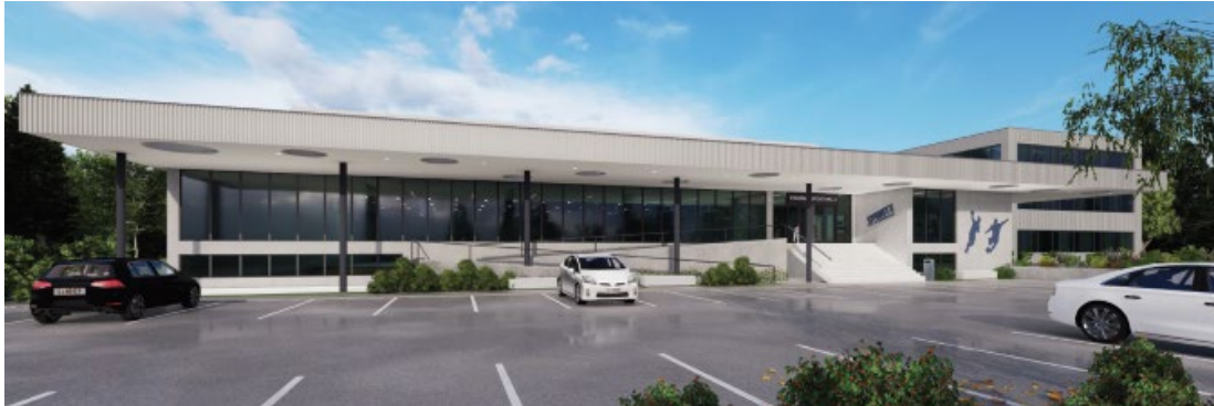
Die ILG KG gab 9,9 Millionen Euro etwa für die Adaptierung der Sport-MS Kleinmünchen sowie Aufstockung und Adaptierung der Dorfhalleschule.
