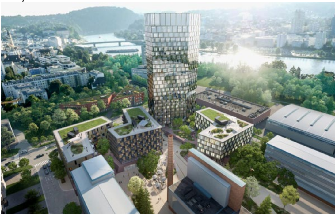
Die Tabakfabrik expandiert erneut und wird um den „Quadrill“ erweitert. Es wurden 9,2 Millionen Euro für die Generalsanierung der Gebäude am Tabakfabrik-Areal investiert. Foto: TFL
