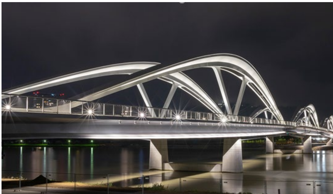
Die Stadt Linz zählte 2020 zu den größten Investoren in die Infrastruktur. 106,2 Millionen Euro wurden investiert. 48,5 Millionen Euro entfielen auf Straßenbau/Verkehr, davon 29,5 Millionen Euro auf die Neue Eisenbahnbrücke. Foto: Stadt Linz
