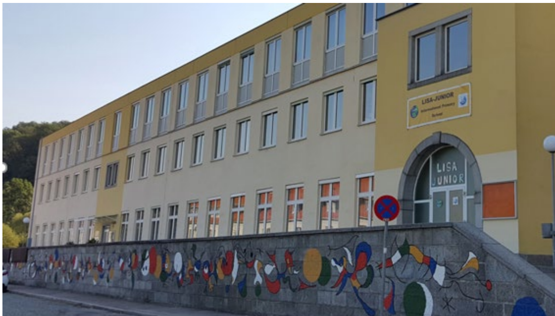
„Strom aus der Sonne“ nach der Sanierung der Volksschule Aubrunnerweg.
