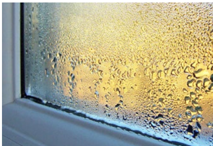
Abb.: Beispiel Kondensation: Wasserdampf kondensiert an der Fensterscheibe, da er dort abgekühlt wird und somit den Taupunkt unterschreitet.
