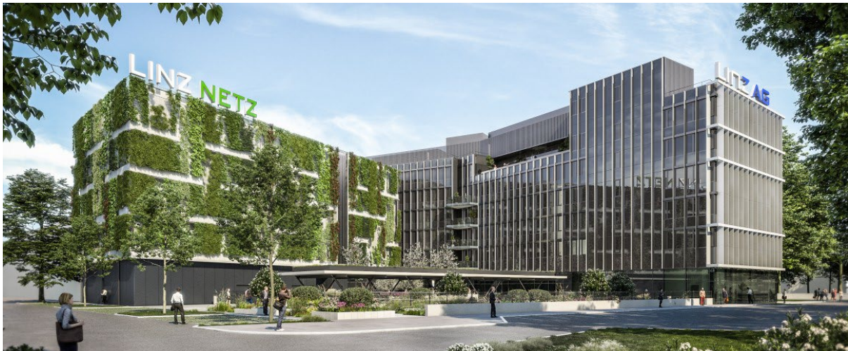
Netzgebäude der Linz AG
