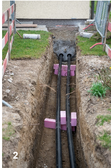
Abb. 1, 2, 3: Rohrleitungen werden vom Straßenzug über das Eigenheimgrundstück direkt ins Haus verlegt.
