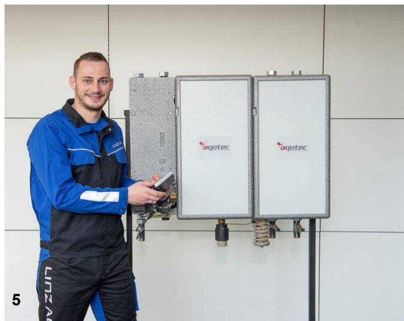
Abb. 4, 5: Installation von Übergabestationen mit digitalem Wärmemengenzähler.
