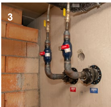
Abb. 4, 5: Installation von Übergabestationen mit digitalem Wärmemengenzähler.
