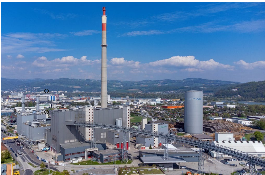
Bildtext: Der Kraftwerkspark Linz-Mitte beinhaltet ein Fernheizkraftwerk, ein Biomasse-Heizkraftwerk, ein Reststoff-Heizkraftwerk und einen Fernwärmespeicher. © LINZ AG/grox
