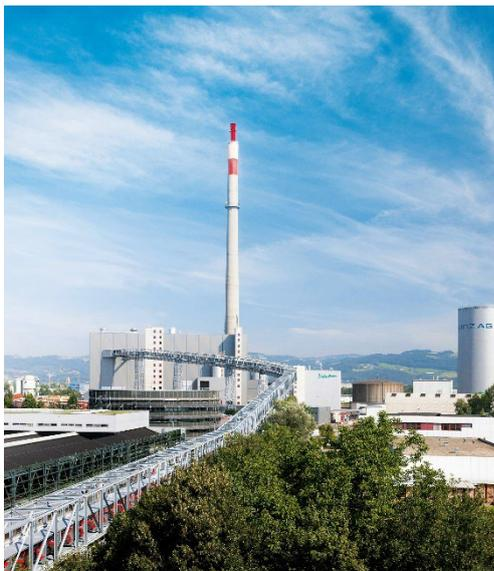
Abb.: 460 Meter langer Rohrgurtförderer (l.) zwischen RABA (r.) und RHKW im Kraftwerkspark Linz-Mitte (l.).
