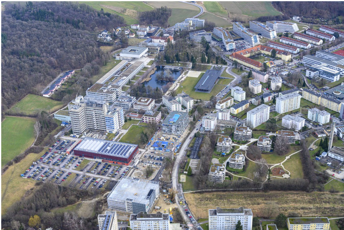
Das Universitätsviertel im Februar 2024. In Bau befindet sich die Erweiterung des Campus West, „House of Schools“; Foto: PTU Pertlwieser.
