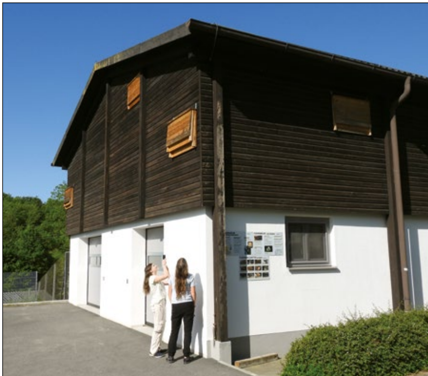
Abb. 3: Kontrolle der Spaltenkästen
