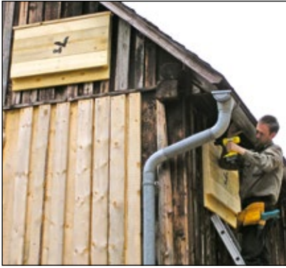
Abb. 13: Montage von Fledermausbrettern – ideal ist es, sie zumindest an zwei Seiten des Gebäudes anzubringen. Die Fledermäuse können dann je nach Witterung und Temperatur die geeigneten Quartiere aufsuchen.
