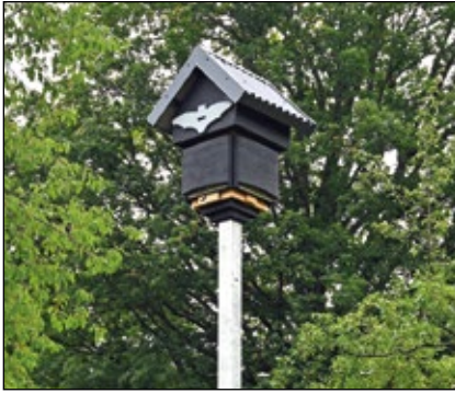
Abb. 9: Fledermausstelen sind freistehende Ersatzquartiere für Spalten bewohnende Fledermausarten. Sie wurden vom Foto- autor und seiner Gattin entwickelt, da sich an Neubauten kaum geeignete Hang- plätze für Fledermausbretter finden. Dazu kommt die mangelnde Bereitschaft vieler Hausbesitzer*innen Ersatzquartiere an der Fassade anzubringen.
