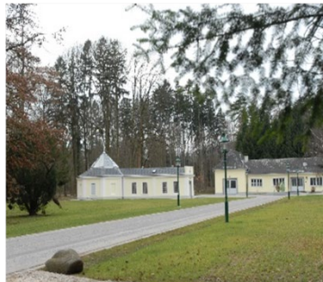
Die vier Wasserwerke der LINZ AG oben von links: Scharlinz, Goldwörth, unten von links: Plesching, Heilham zweitälteste Wasserwerk in Linz und ging 1902 in Betrieb Fotos: LINZ AG
