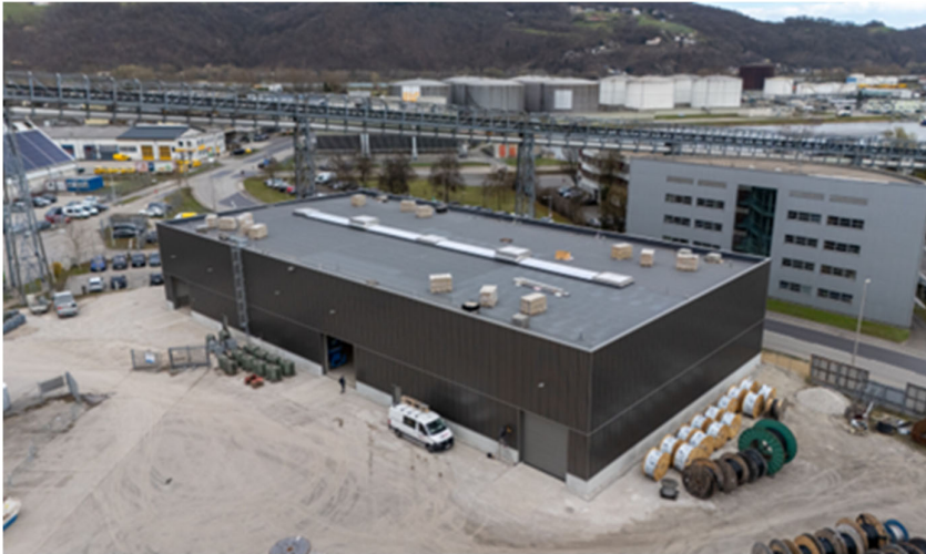
Abb.: neue Lagerhalle im Energiepark Linz-Mitte.
