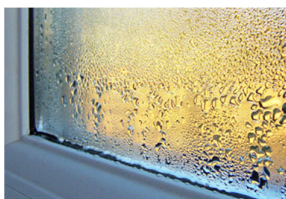
Abb.: Beispiel Kondensation: Wasserdampf kondensiert an der Fensterscheibe, da er dort abgekühlt wird und somit den Taupunkt unterschreitet.
