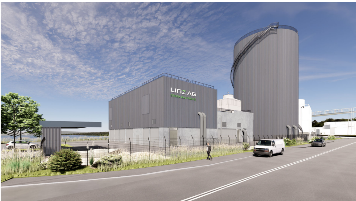
Die neue Fernkältezentrale mit Fernkältespeicher entsteht im Energiepark Linz-Mitte.
