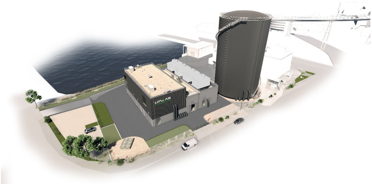
Ansicht der neuen Fernkältezentrale auf dem Areal des Energiepark Linz-Mitte.
